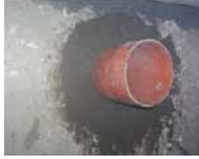
2. Harç ile renovasyon ve güçlendirme sonrası 2. Mortar for renovating and reinforcing
